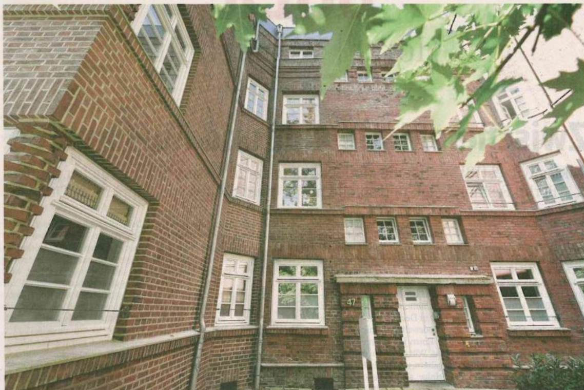
Eine Ansicht der renovierten Backsteinhäuser des Architekten Josef Franke an der Liebfrauenstraße.
